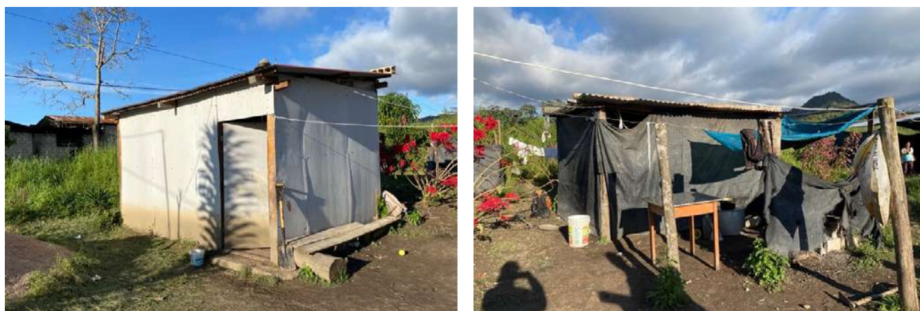
Figura 8. Ejemplos de viviendas de diferente calidad y materiales de construcción en las regiones cacaoteras y cafetaleras de San Martín, Cajamarca, Junín y Cusco, mayo/junio de 2022
